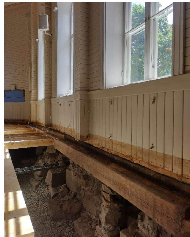
Kirkon päälaivan eteläseinää on korjattu koolauksilla ja paneloinnilla suuremmaksi vuonna 1925. Alaosassa sisäpaneeli on kiinni hirressä. Seinä nojaa ulospäin n. kymmenisen senttiä korkeutensa matkalla. Valokuva alapohjan korjaustyömaalta kesäkuussa 2024.
