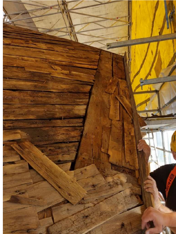
Vanhoja päreitä paljastui vanhan peltikatteen alta kuorin etelälappeella kesällä 2023.
