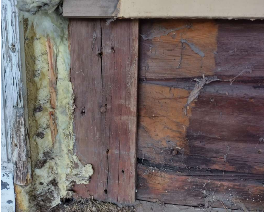
Eteläsiiven lännenpuoleinen ulkoseinä. Hirret on punamullattu tummalla faluninpuneisella ennen laudoituksen asentamista. Myöhemmin vaihdetut ikkunat on tiivistetty polyuretaanivaahdolla ja lasivillalla. Kirkko on laudoitettu vuonna 1825 ja maalattu punaiseksi 1828.
