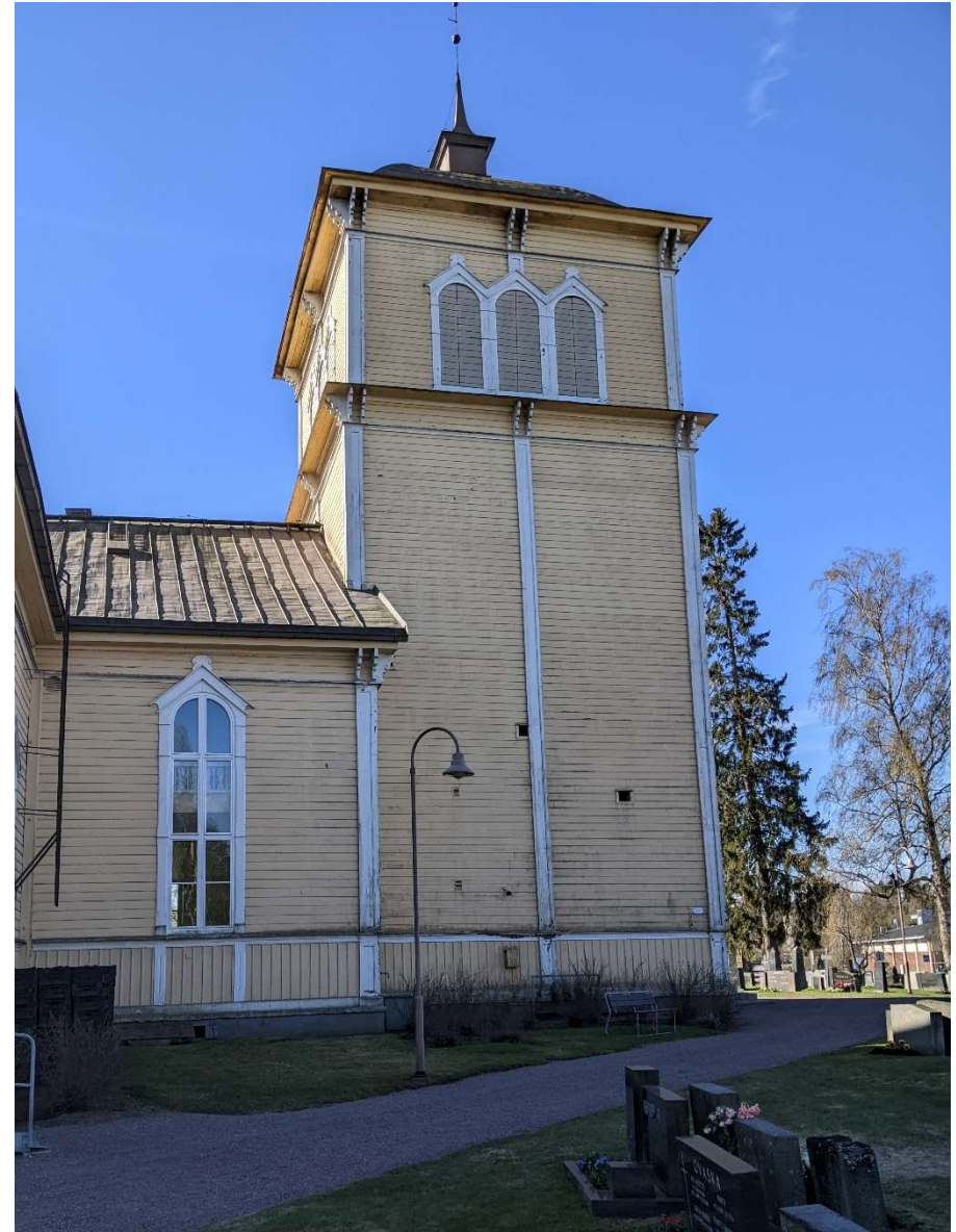
Kustaa Aadolfin kirkon julkisivu kuvattuna 2023. Julkisivu vuoden 2009 maalipinnalla.
