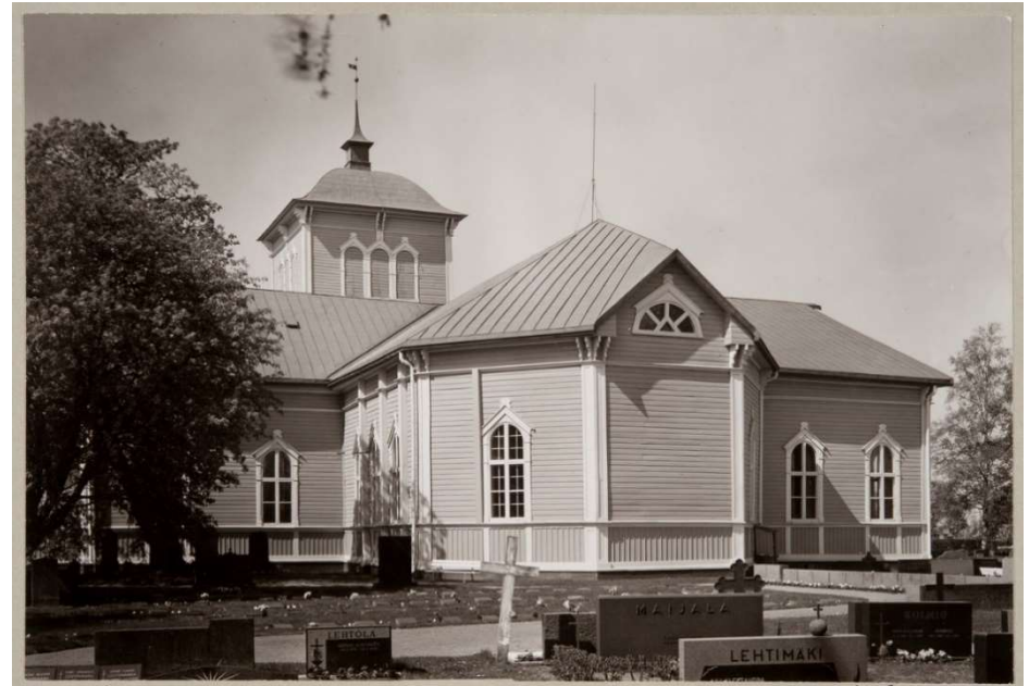
Kuvassa vuodelta 1978 alttarin oikealla puolella olevan ikkunan sisäpuiteet näyttävät moniruutuisilta. Muissa ikkunoissa samaa ei ole havaittavissa. Museovirasto, historian kuvakokoelma, Per Olof Welin 1978. Nämä kuvassa näkyvät pääkerroksen ikkunat ovat tiettävästi vuodelta 1925, ja ne uusittiin jälleen 1988.
