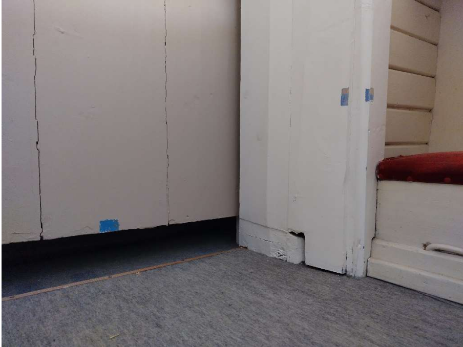
Yllä: Saarnastuoliin johtavan oven ja sen listoituksen alaosista otettiin väritutkimuksen yhteydessä esiin alkuperäisiä sinisiä sävyjä. Oikealla: Saarnastuolin sisäänkäynti on vuodelta 1803, pintakäsittelyt 1980-luvulta.
