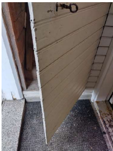
Sisään tullessa vasemmalla puolella seinässä on piilo-ovi, josta pääsee torniin johtavaan portaikkoon, kuva ennen 2024 korjaus- ja muutostöitä.
