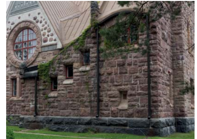
Rubble-muuria Luvian kirkon julkisivupiirustuksessa (Stenbäck 1908, SRKA). Oikealla kuva toteutuneesta seinästä samalla nurkalla (kuva vuodelta 2022).
