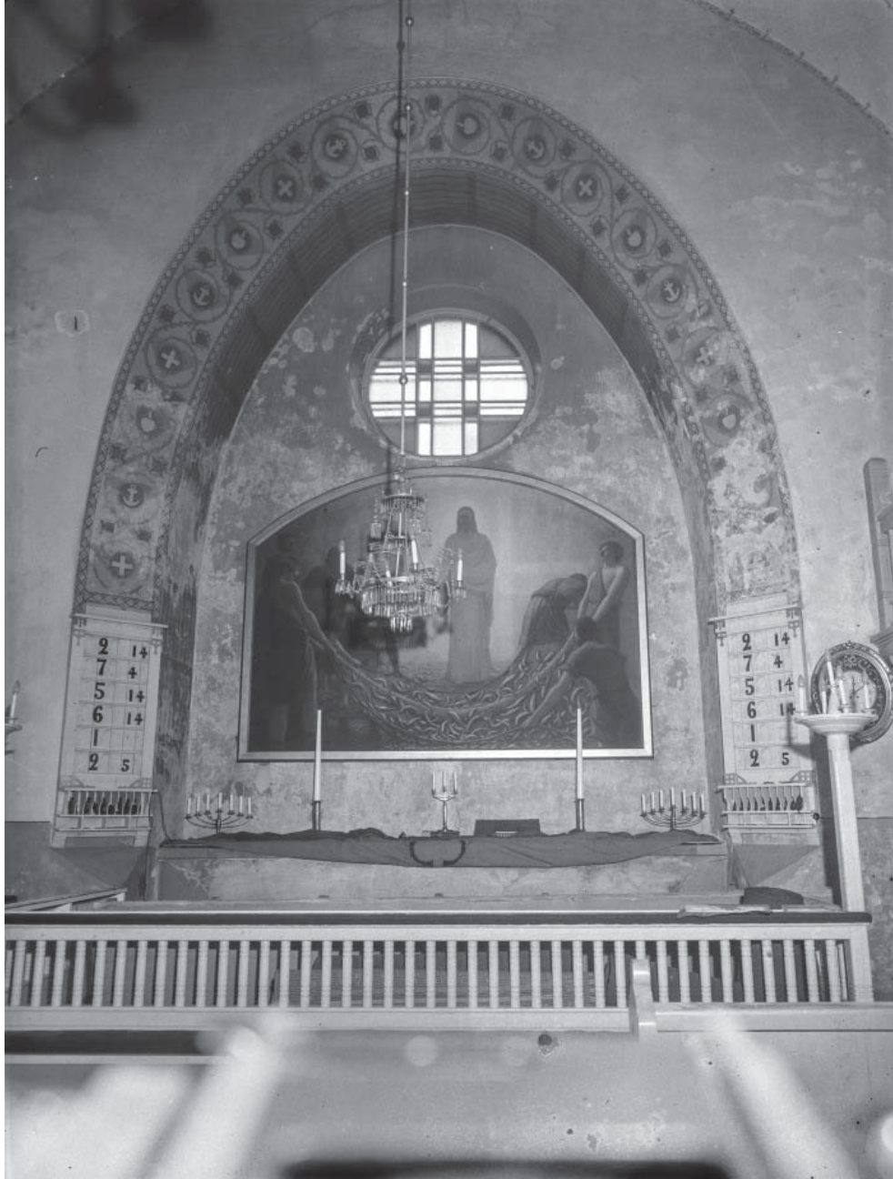
Satakunnan Kansa 9.12.1962: Kosteus turmelee Luvian kirkkoa. Home on pahoin turmellut mm. kirkon kuorissa olevia maalauksia ja kirjavoitnut seinäpinnan laikkuisiksi.
