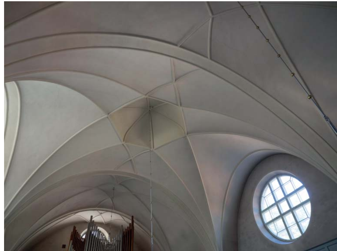
Kirkon holvien esikuvana Stenbäckin arvellaan käyttäneen Ulvilan keskiaikaisen kirkon ns. stureholveja. Alunperin holvien ruoteissa ja vyökaarissa oli koristemaalauksia. Nämä peitettiin vuoden 1963 peruskorjauksessa.
