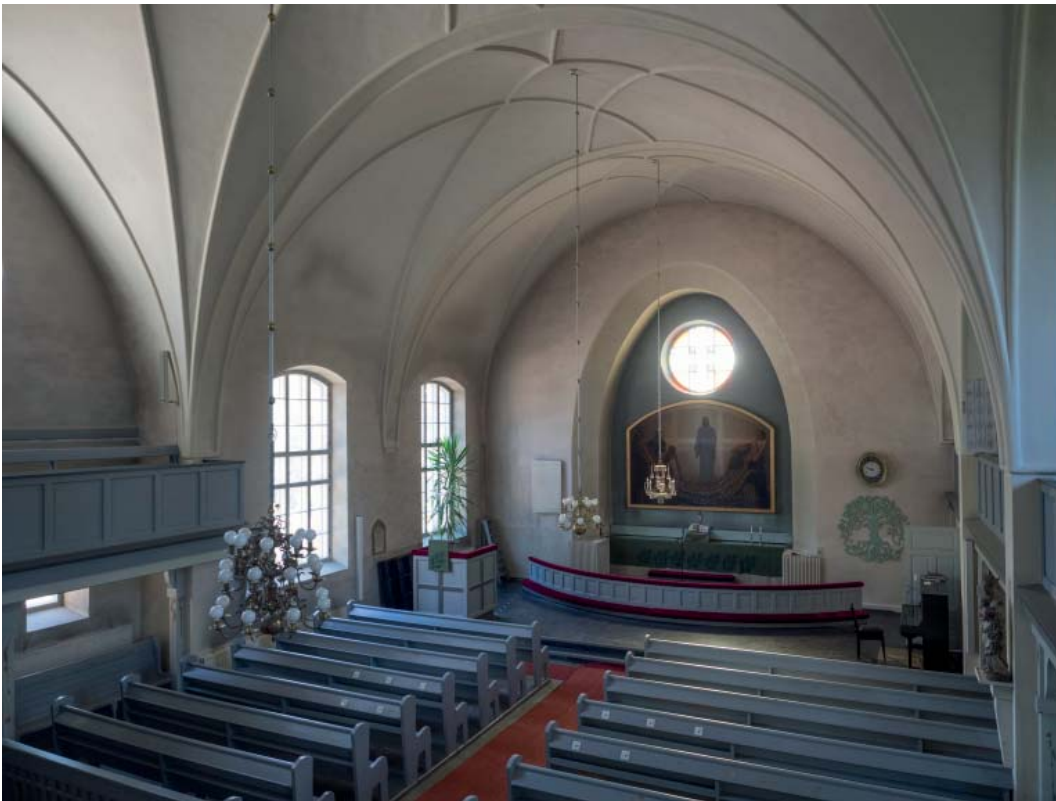
Kirkkosali urkulehteriltä kuoriin ja alttarille päin. betonirakenteista, rapattua holvikattoa
